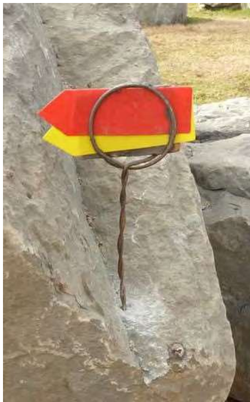
Trapanare direttamente nell'ostacolo
